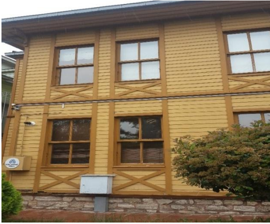
Şekil 11. Kızılmescit Sokak Yapı Örneği(2018)
