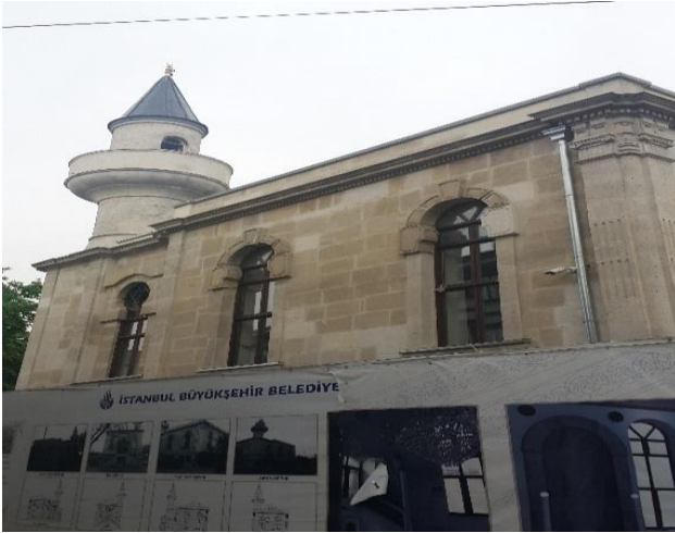
Şekil 20. Kaptan Paşa Camii Restorasyon süreci (2018)
