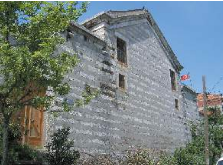
Resim 22; Surp Asdvadzadzin Kilisesi doğu cephesi
