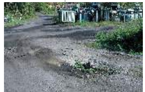
Resim 25. Çökmüş soğutma suyu kanallarından biri.
